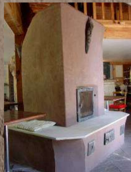
Poêle finlandais avec banquettes, cheminée maçonnée. Finitions : enduits à l'argile et dalle de gré
