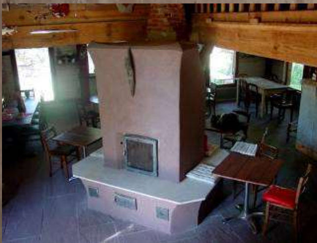
Poêle finlandais avec banquettes, cheminée maçonnée. Finitions : enduits à l'argile et dalle de gré
